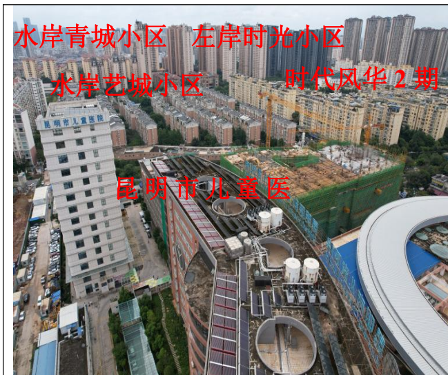
图 7 项目东南侧环境现状
