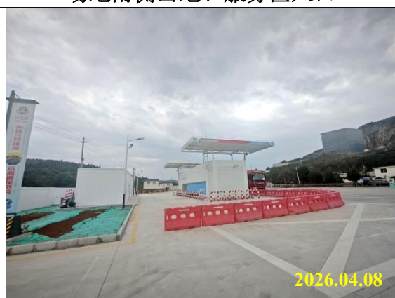
建设场地现状
