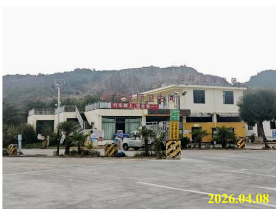
场地北侧（加水站卫生间、营业室）
