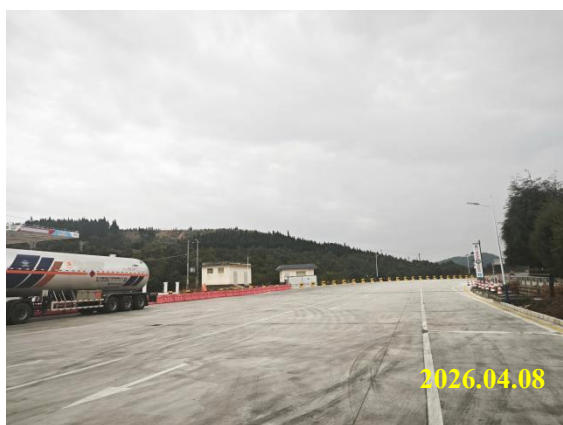
场地南侧山地、服务区入口
