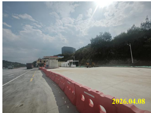
建设场地现状、西侧山地
