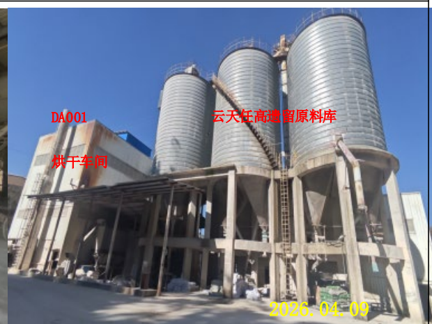
项目区生产区南侧现状（废气处理设施）
