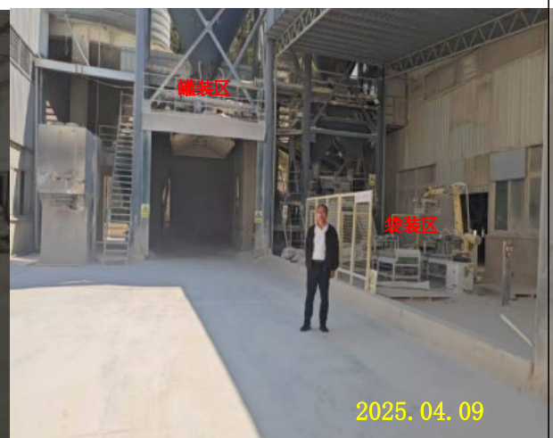
项目包装区现状（工程师现场图片）
