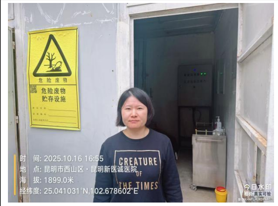
项目污水处理系统加料间
