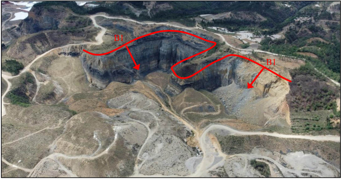
图 2.2-5 B 1 崩塌全景
