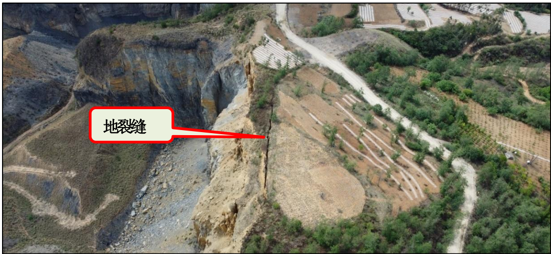
图 2.2-11 L_1 地裂缝全景
