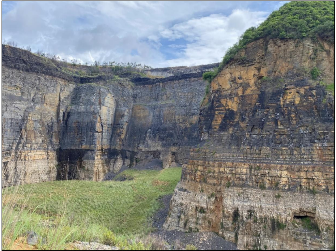
图 2.2-6 B 1 崩塌局部照片
