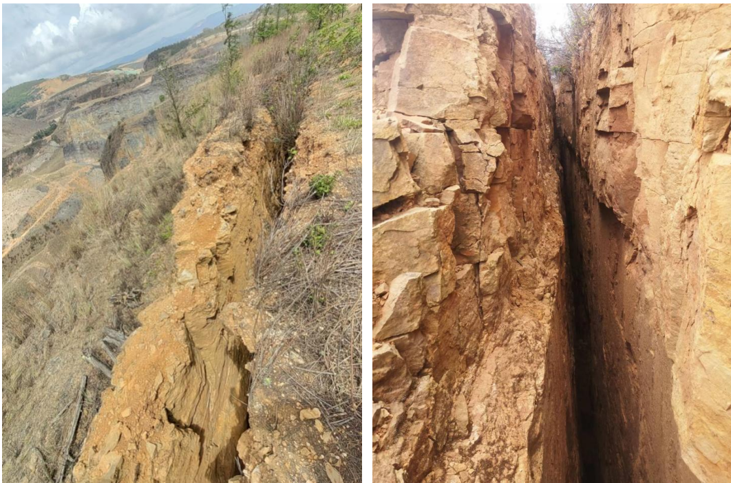
图 2.2-12 L_1 地裂缝局部
