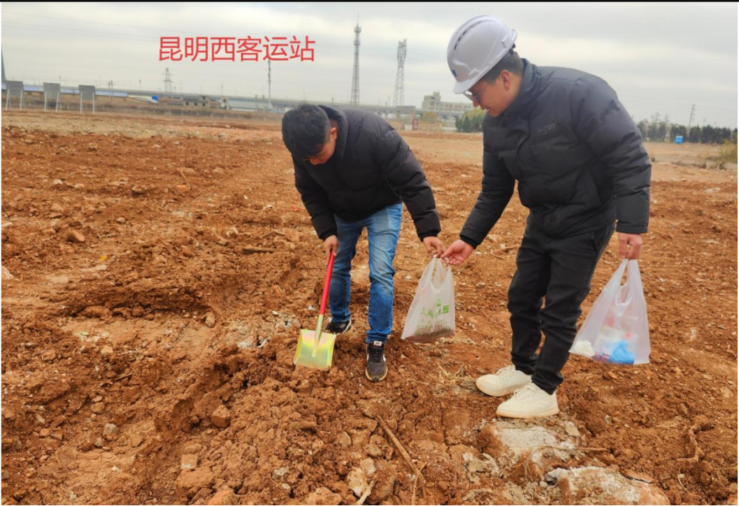
图2-3 土源点5现场照片
