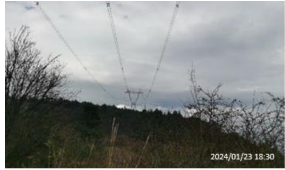
下穿 500kV 和平厂口 II 回
