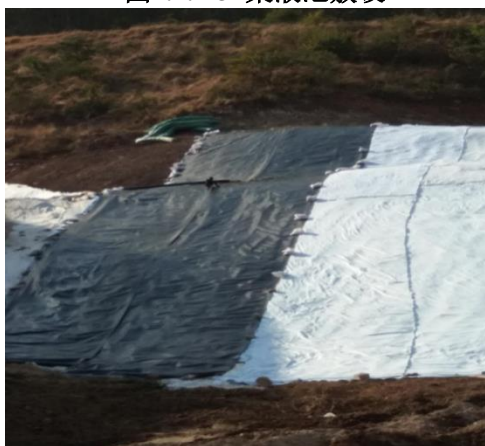
图2.1.4-5 岸坡两布一膜
