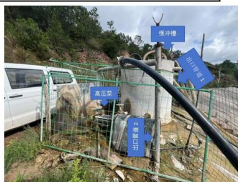
二级高压泵及缓冲槽
