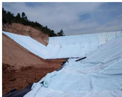
图2.1.4-4 集液池岸坡防渗膜敷设
