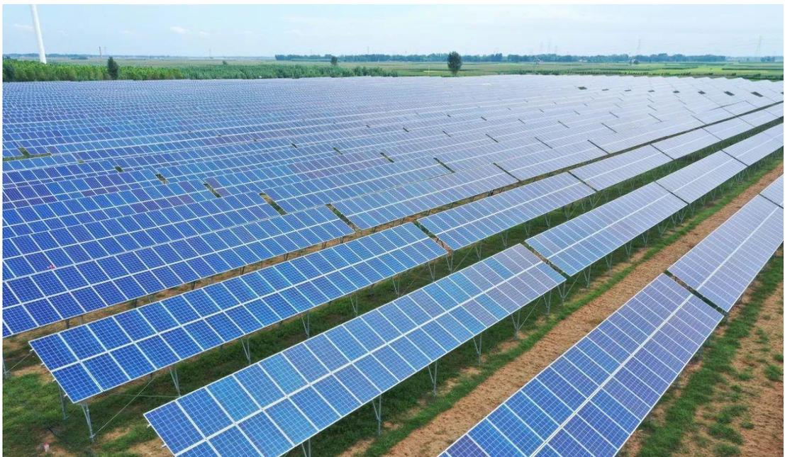
图 2-2 固定支架太阳能方阵示意图
