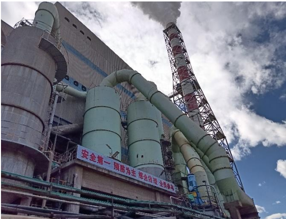
现有尾气洗涤系统及排气筒
