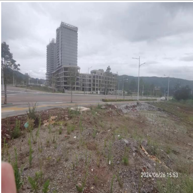
项目区东侧（在建中心）
