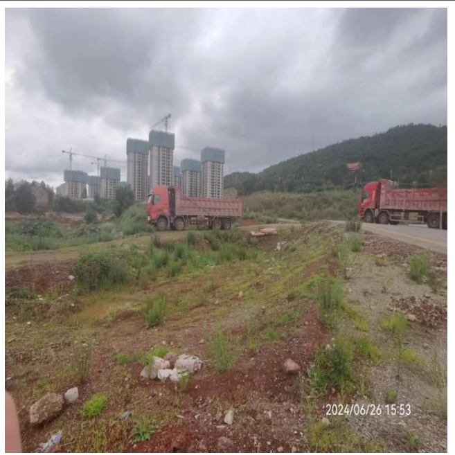
项目区西侧（在建新庄村）
