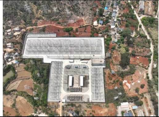
220kV 马鞍山变电站现状
