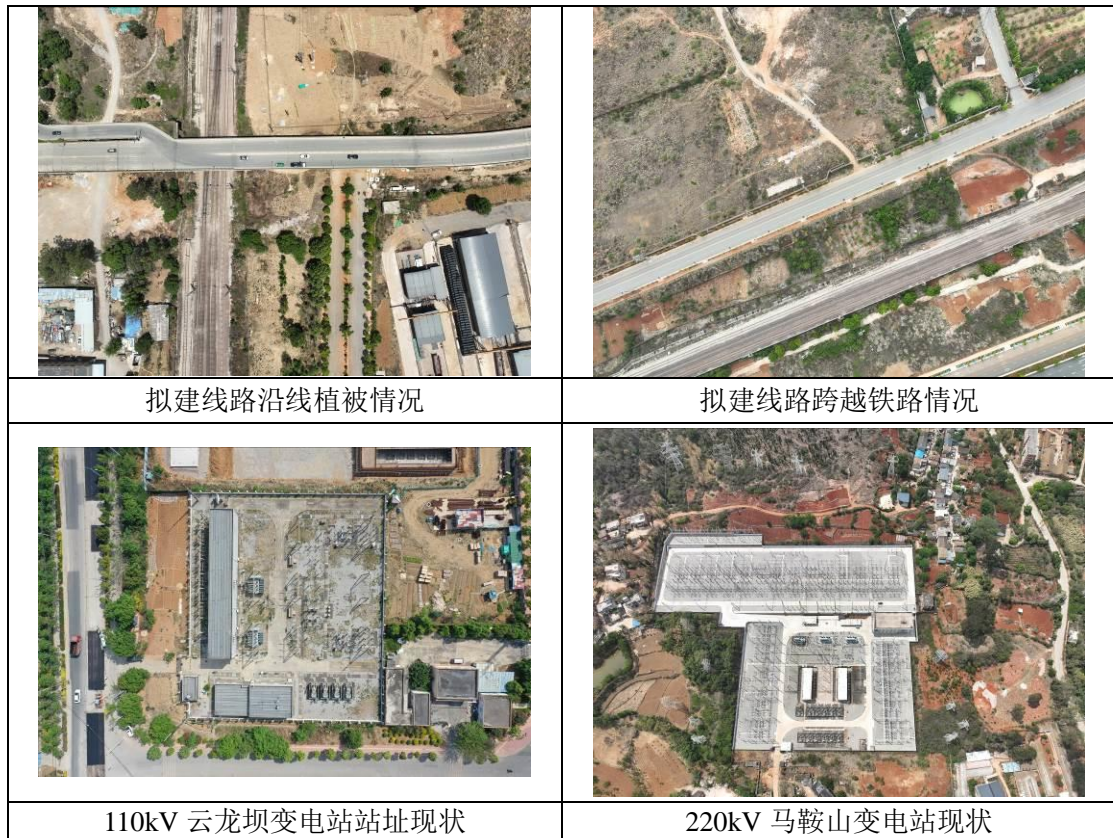
图 13 本工程区域自然环境现状
