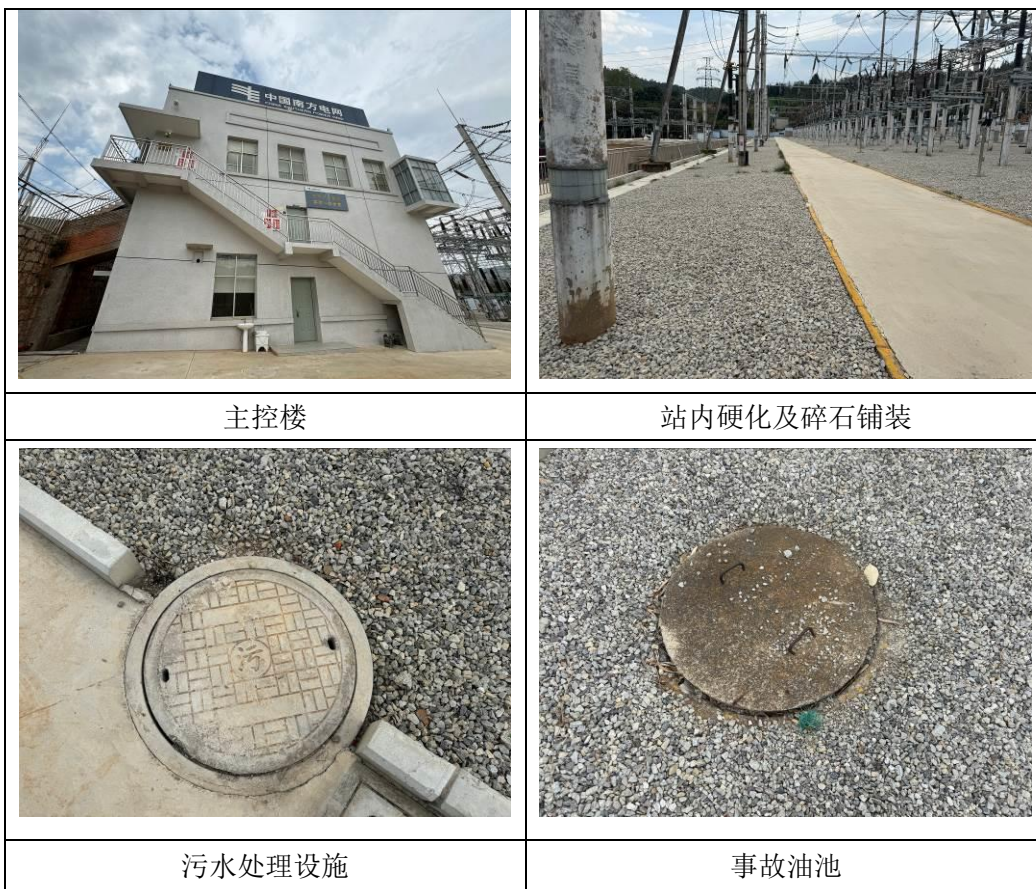
图 3 220kV 马鞍山变电站实景照片
