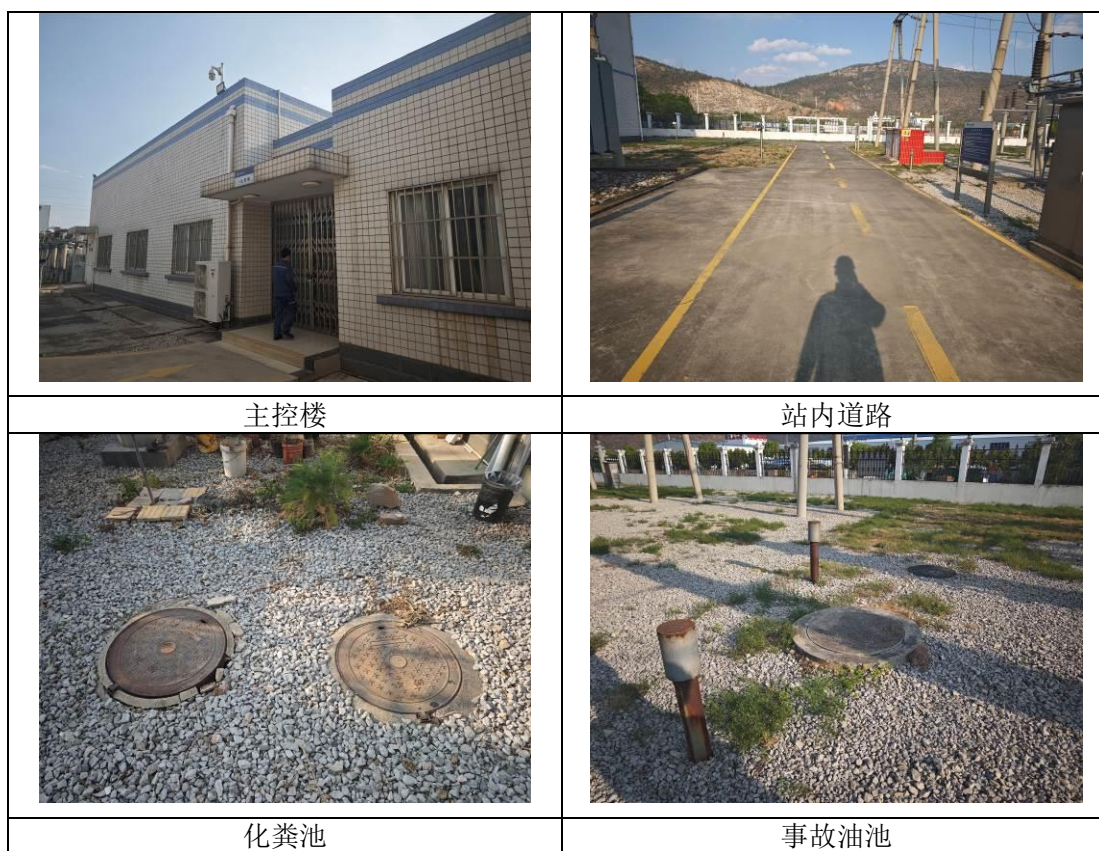
图 2 110kV 云龙坝变电站实景照片
