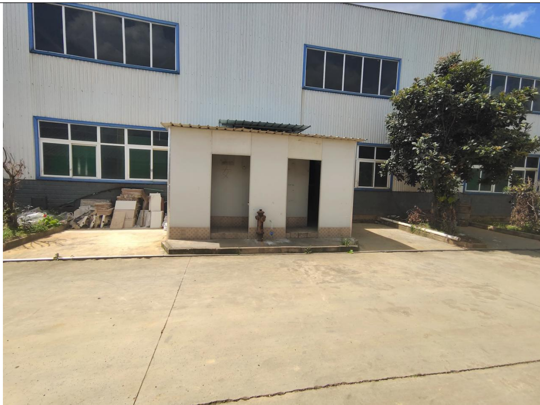
云南滇威新能源科技集团有限公司厂区内已建成公厕
