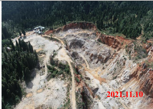
项目区原矿山采空区现状
