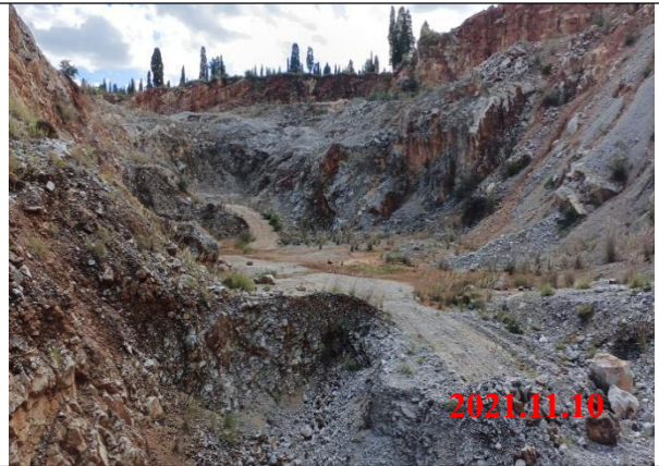
项目区原矿山开采边坡现状
