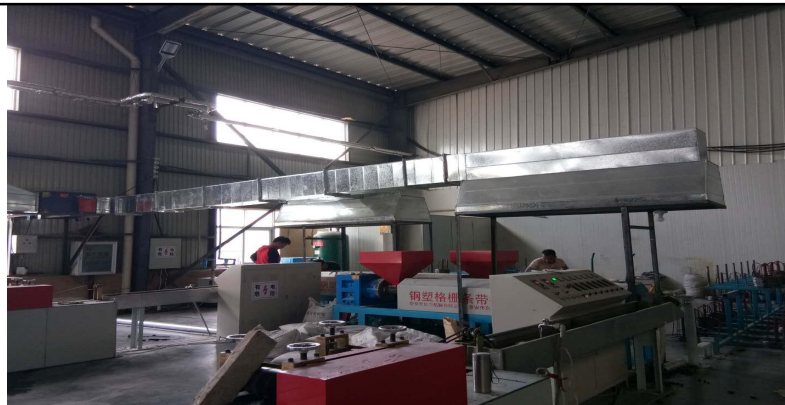
图 4-1 项目有机废气收集设施实施参考图
